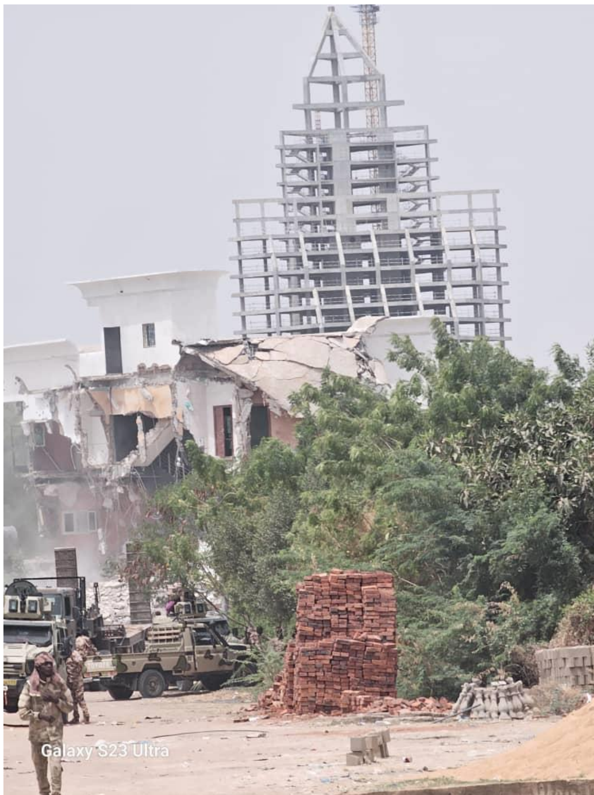
Illustration 2 : Démolition du siège du PSF
